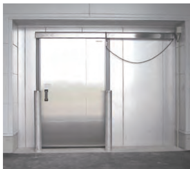
半自動駆動装置の写真 Semi-automatic drive unit
