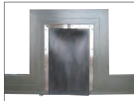
小窓部分写真 Small access port
